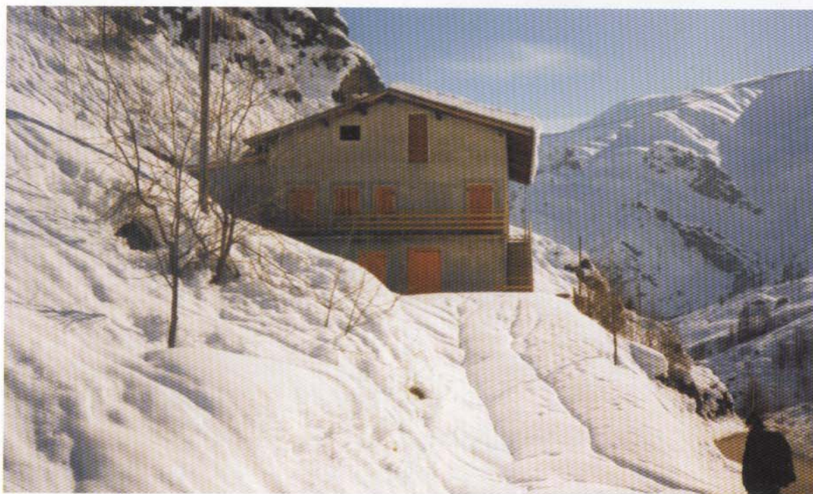
Una immagine della Casa Alpina al termine del primo stralcio di lavori dell'edificio.
